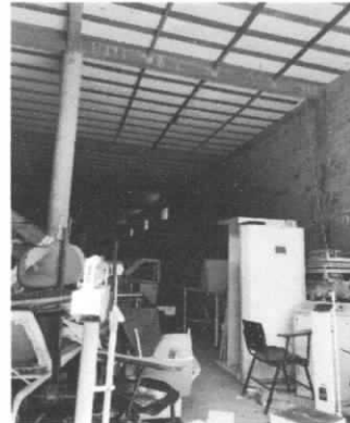
FOTO 04 - ÁREA INTERNA DO GALPÃO
